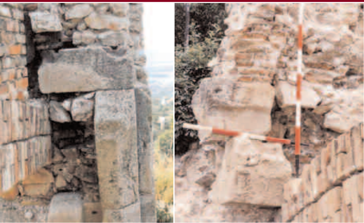
A déli oldal felső, kettős csigaperselye (balra), és az északi oldal felső perselykövei (jobbra)
