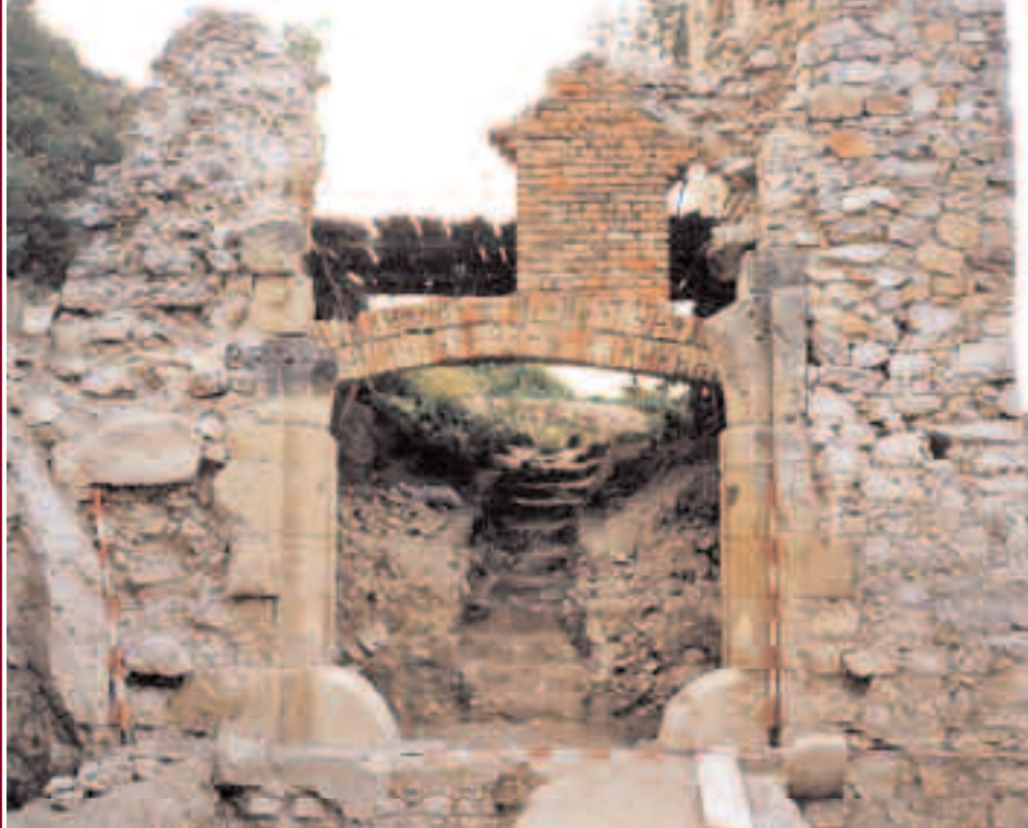
A torony felvonóhidás–csapórácsos gótikus kapuzata
