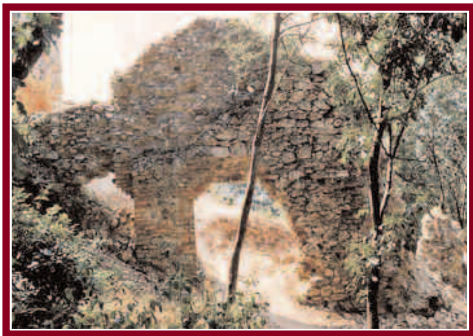
A barbakán bejárata a feltárások megindulása előtt (a kapurést 1962-ben támasztották alá egy téglapillérrel)
