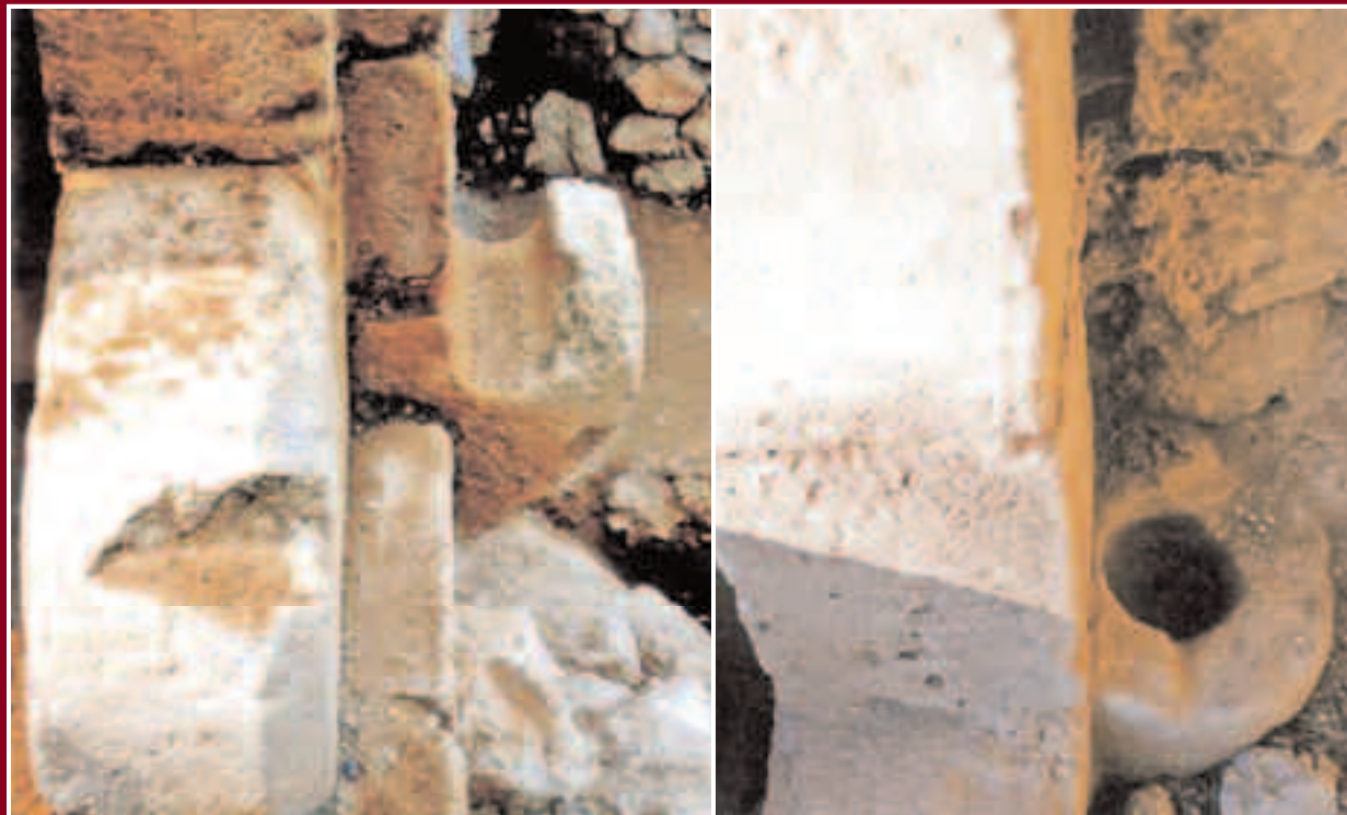
A felvonóhíd déli konzolos perselyköve a kerékvetővel (balra), és a belső fakapu alsó perselyköve (jobbra)
