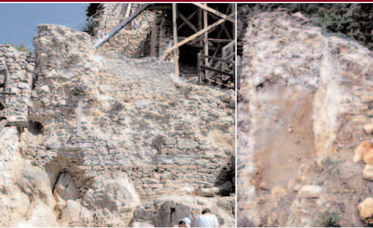
A kápolna elé húzott török fal homlokzata (balra) és a belül kazettás fal földkitöltése (jobbra)
